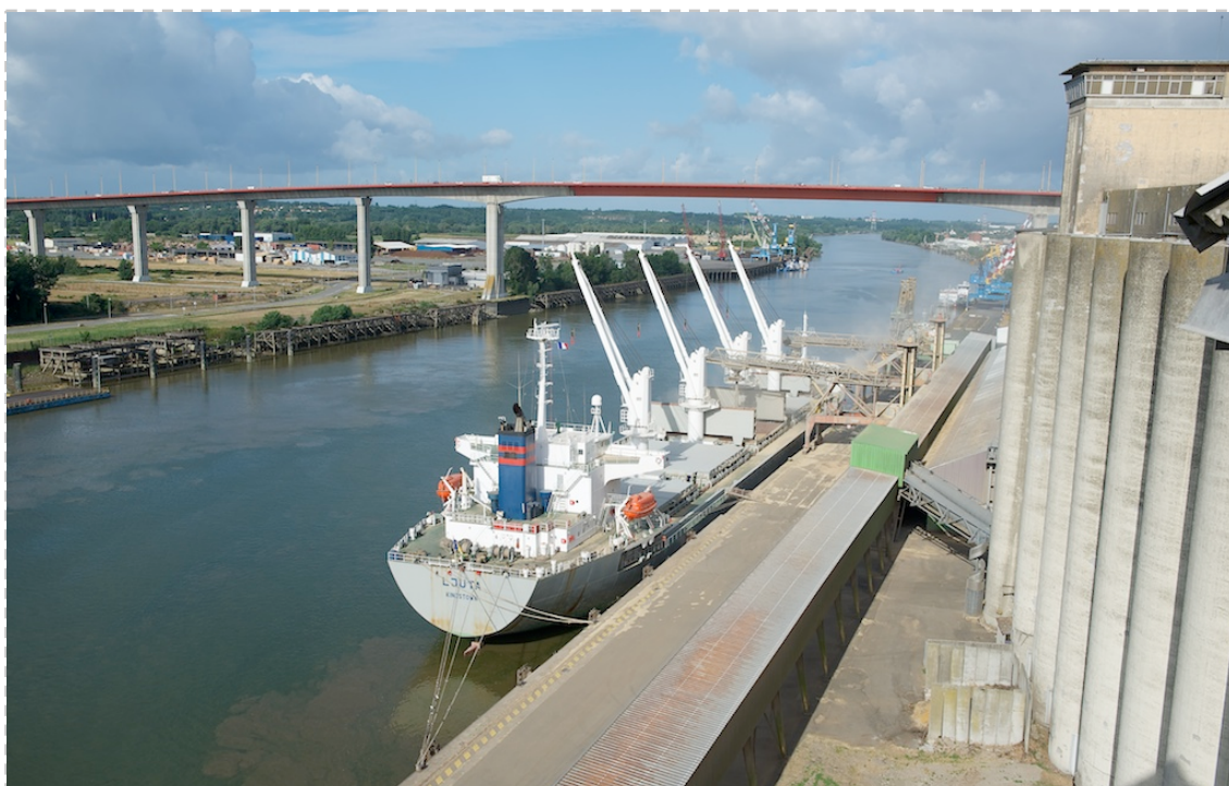
Navire en escale au quai de Roche Maurice - Chargement de blé
